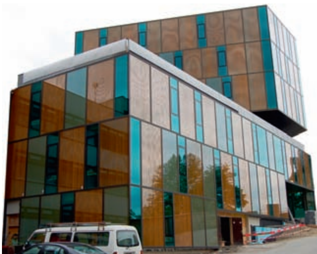
Figure 1 Nouveau bâtiment du Centre professionnel de Fribourg, entièrement vitré et à fort apport solaire passif. Différents types de vitrages sont mis en œuvre pour bénéficier au mieux de l'apport énergétique solaire.
